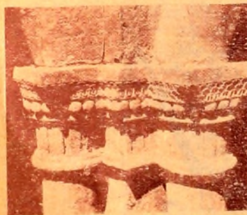
Detalle de las columnas del claustro principal
