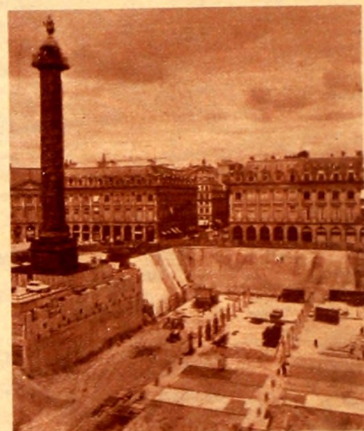
Enorme playa de estacionamiento en construcción en la Plaza Vendôme
