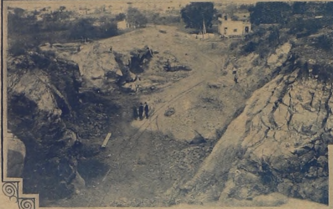
Arriba: Parte de la carretera que se construye de San José a Mercedes. — Abajo: Las grandes canteras de donde se extrae la piedra para la construcción de la referida carretera
