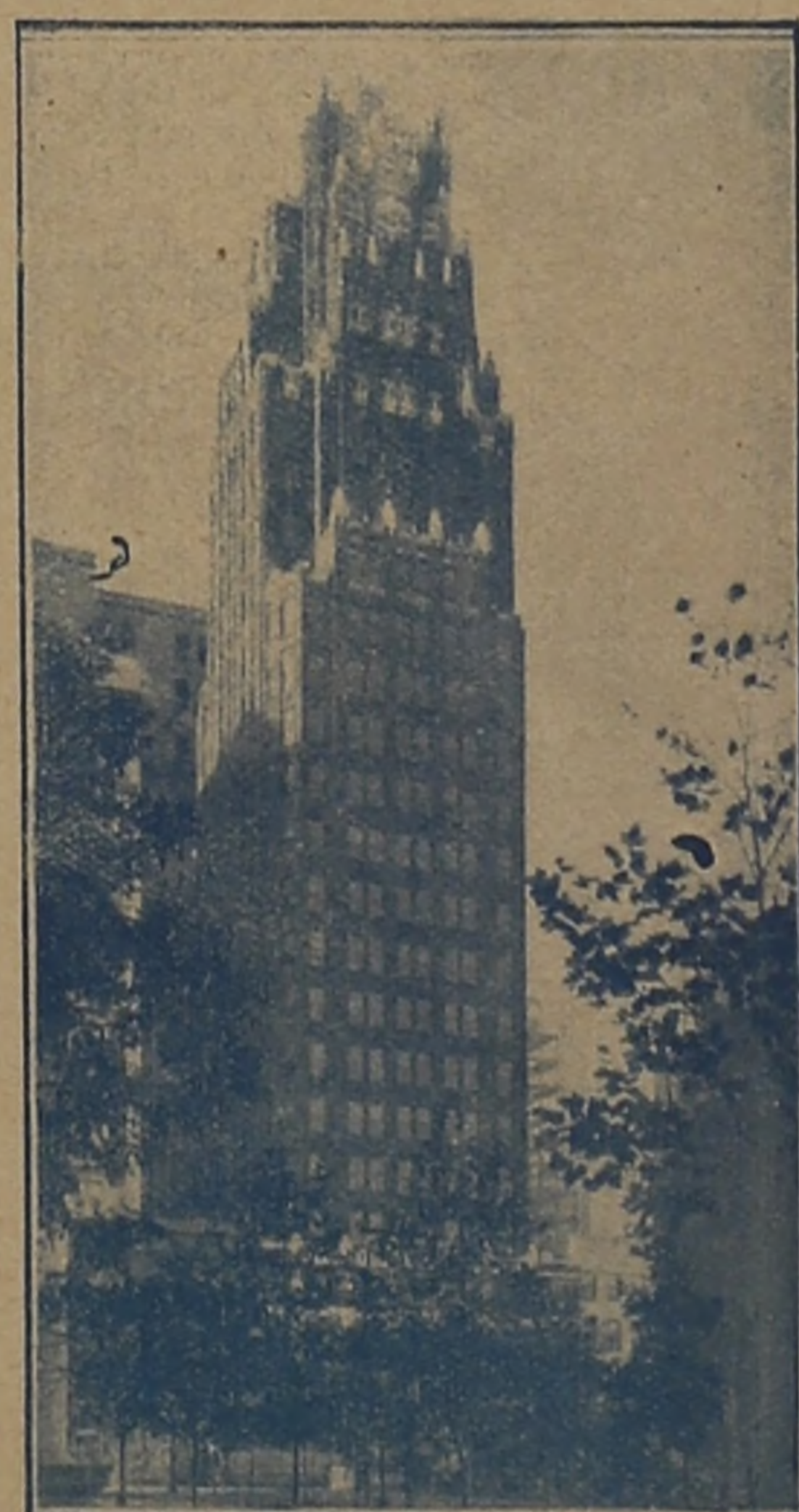
Otro original exponente de la arquitectura americana, el edificio del American Radiator, obra del Arquitecto Hood.
