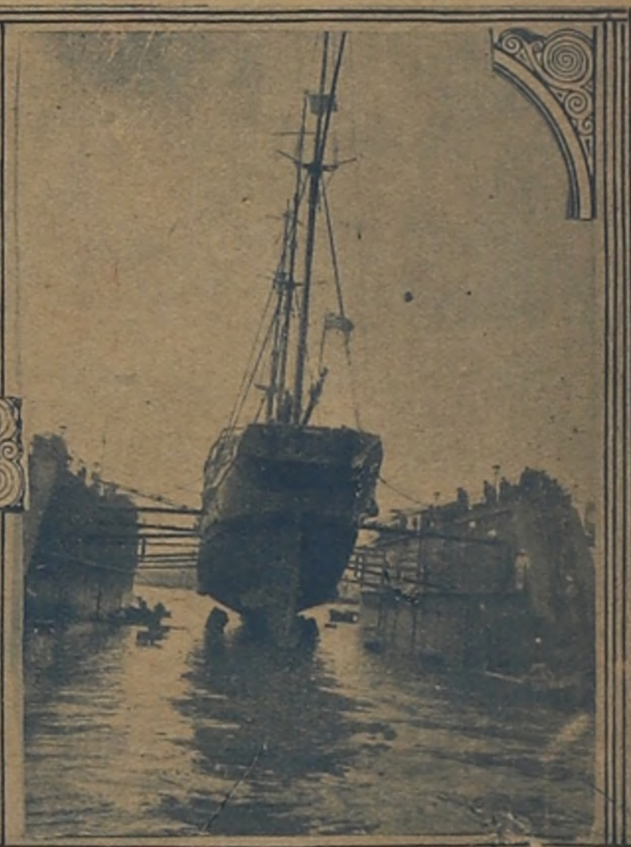
La cañonera nacional, con su casco en descubierto después de haberse elevado el dique sobre el nivel del mar
