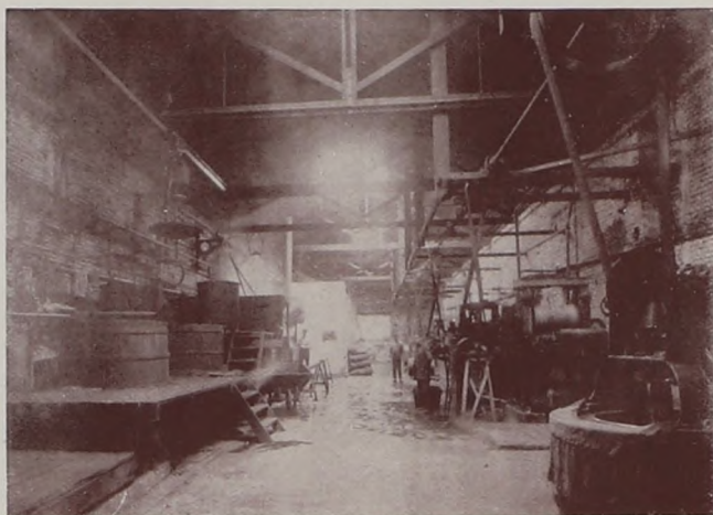
Sección tintorería y lavadero de lanas Al fondo sección de chopones. — Fábrica en Paso del Molino
