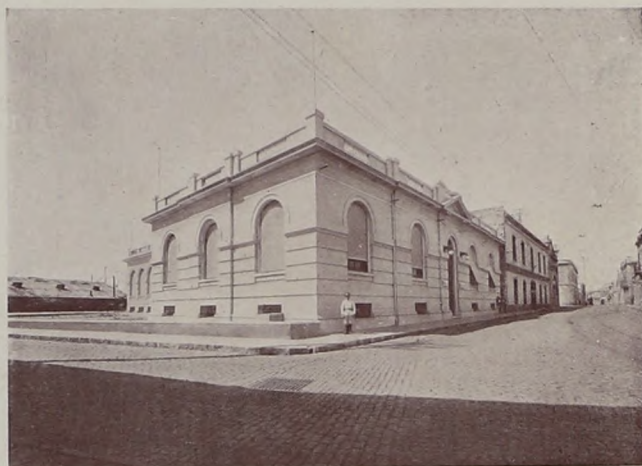
Edificio de la Administración Nacional del Puerto
