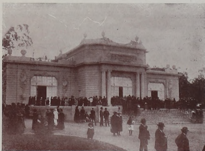
Edificio del Hotel del Prado
