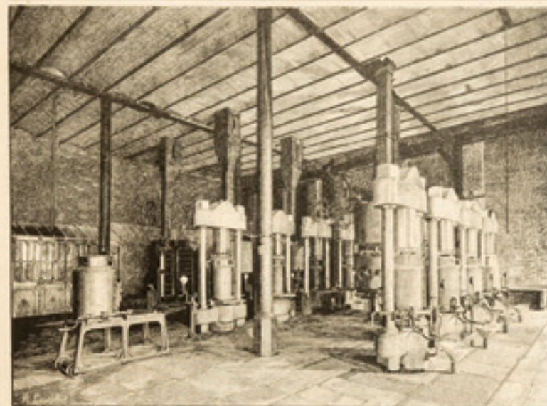
Interior del establecimiento de máquinas de vapor de la fábrica de la Compañía de los Andes
