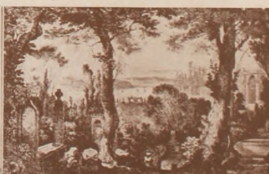
El Cementerio, que se utiliza como paseo
