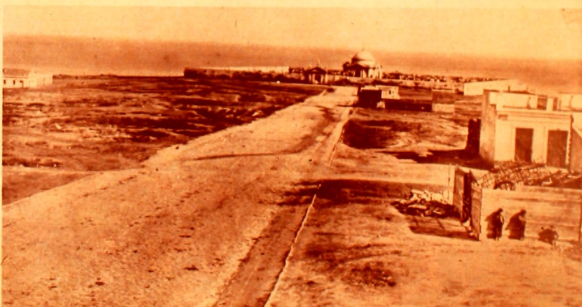
La Rotonda del Cementerio Central y sus alrededores hace un siglo. Proyectada por el Arq. Poncini en 1860, llegó así hasta nosotros. Sus líneas y la distribución de fachadas son características de sobriedad "en la armonía de las masas y en la ordenación de las formas derivadas del clásico romano y renacentista"... nota estética dominante a mediados del siglo pasado. La avenida que se ve en el medio de la foto corresponde, aproximadamente, a la actual calle Yaguarón.
