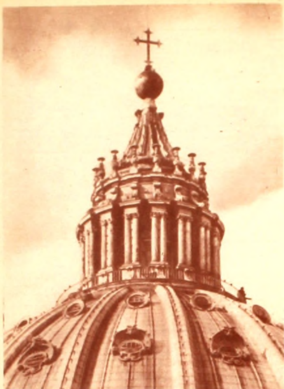
El cupulín de la gran obra de Miguel Angel. Con la cruz la altura del templo llega a m 132,50 sobre el nivel del suelo.
