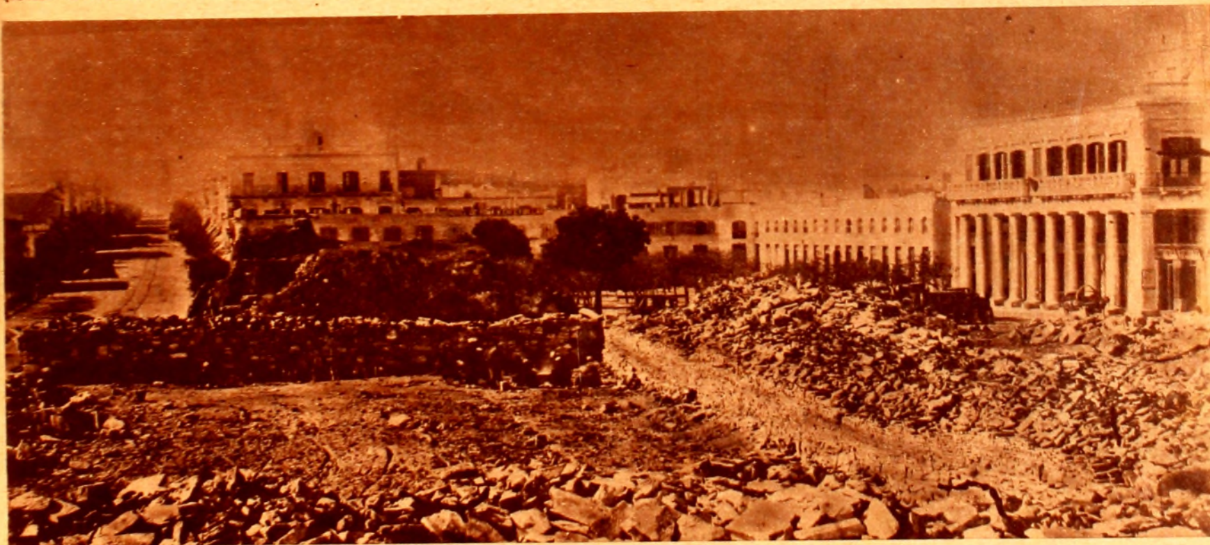
Estado en que se encontraba la Plaza Independencia entre los años 1876 - 77 cuando se demolió lo que aun restaba de la Ciudadela. A la derecha se puede apreciar la actual Casa de Gobierno. A la izquierda, la Avda. 18 de Julio.
