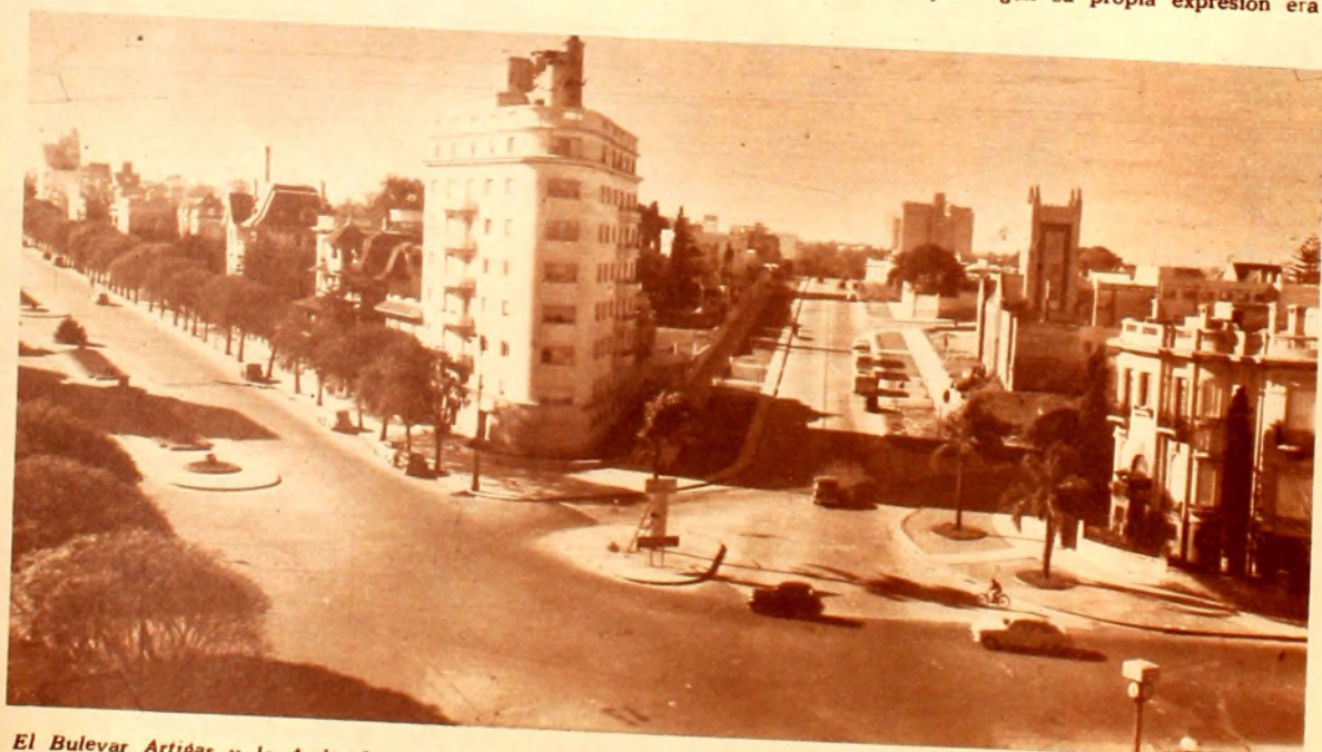
El Bulevar Artigas y la Avda. Luis P. Ponce cuando se abrió esta última. Un conjunto edilicio agradable superado hoy por la magnificencia de sus construcciones. A la derecha, en primer plano, el Palacete de Piria.
