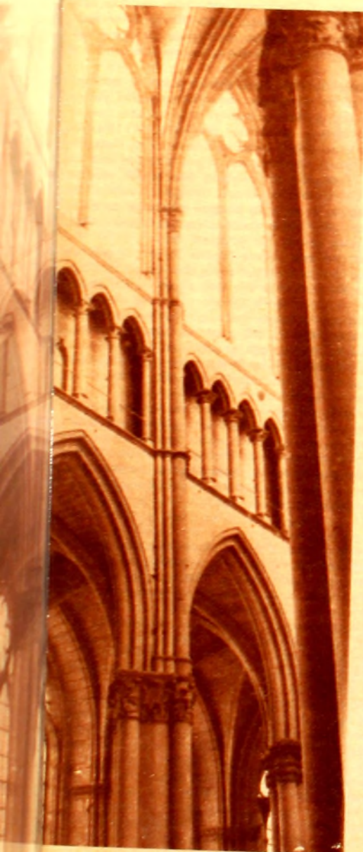
Los vitrales destruidos no se han puesto vidrios comunes.
