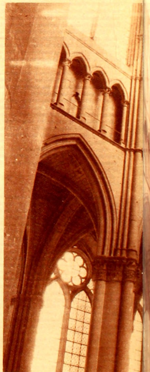
Detalle de la nave central y lateral. D. han podido ser reemplazados y, en s.
