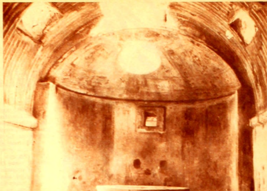
Calidarium , con el labrum o pileta de abluciones. Obsérvese las aberturas superiores para la iluminación y el perfecto estado de los revocos parietales.
