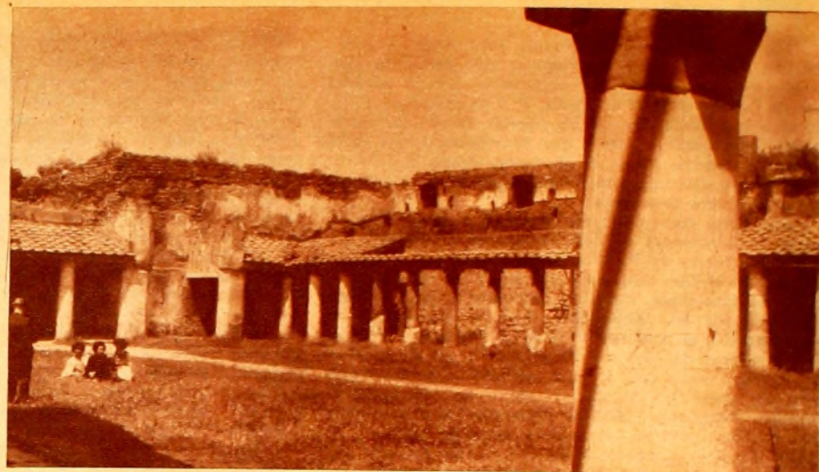
Campo de juegos y gimnasio de las Termas Estabianas, circundado de un pórtico para abrigo y sombra.
