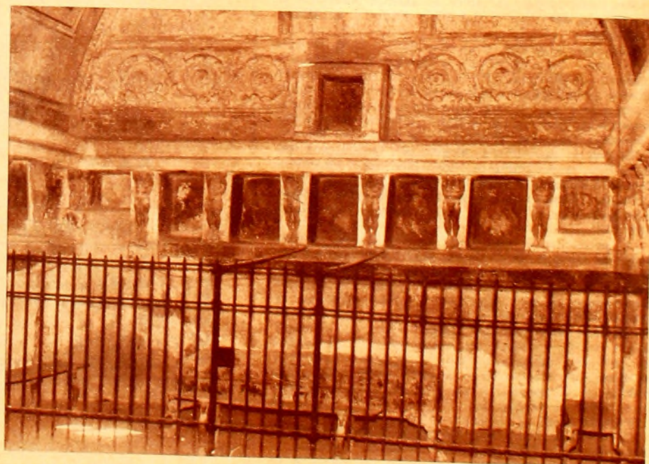
Termas del Foro. Braseró y bancos de bronce regalados por Marco Nigidio Váccula. La reja de protección es contemporánea. Obsérvense las hornacinas o nichos guardados por ropas marginados de cariátides.
