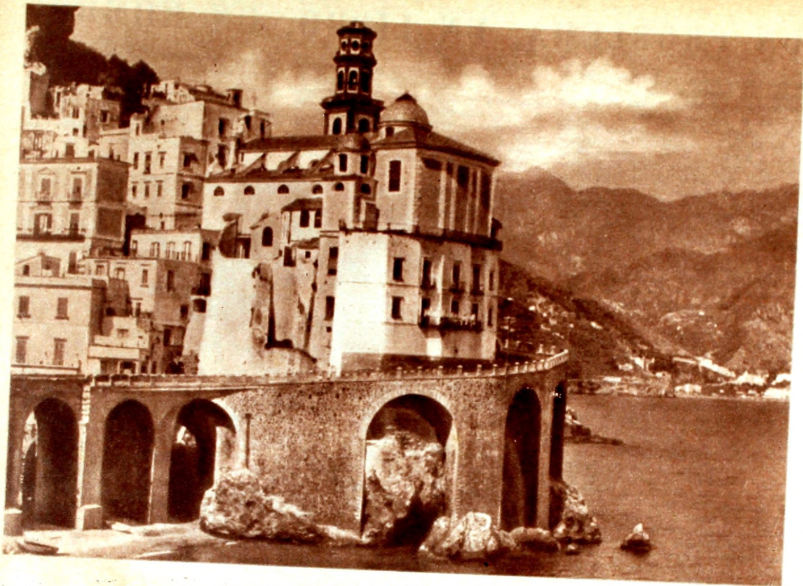
Afrani. Viaducto sobre el mar en la "Strada Statale Nº 183".
