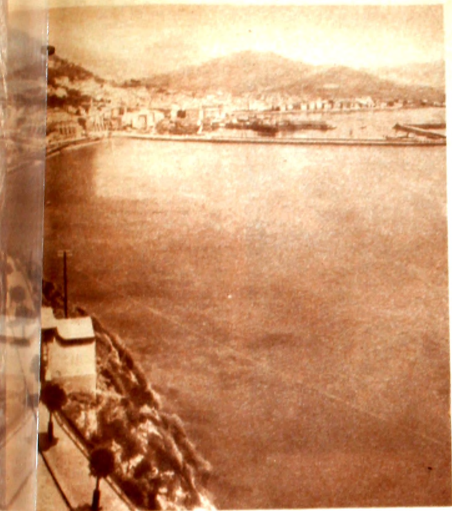
Strada Statale N° 18.
