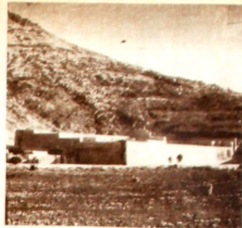
Vista general del Palacio de Puruchuco. A la izquierda, los corrales dispuestos para guardar animales de carga y consumo de los antiguos moradores. Foto del autor.
