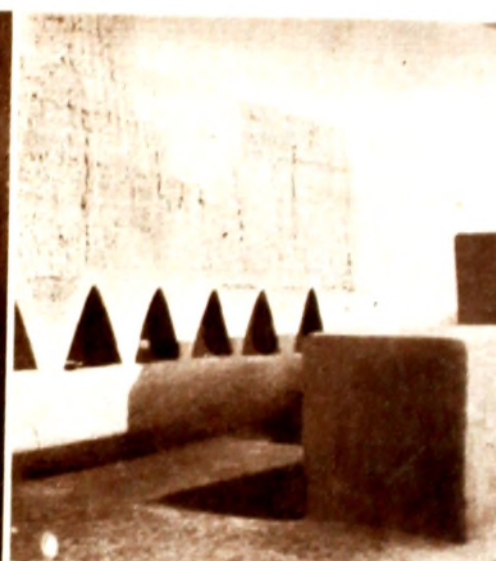
Las seis hornacinas triangulares, elementos arquitectónicos clásicos de la época incaica y ligados con el diario culto al sol. En la ilustración se pueden apreciar las partes revocadas con barro. Son éstos los detalles reconstruidos. Mientras que donde se ve el adobe es lo existente desde el origen del edificio. Foto del autor.
