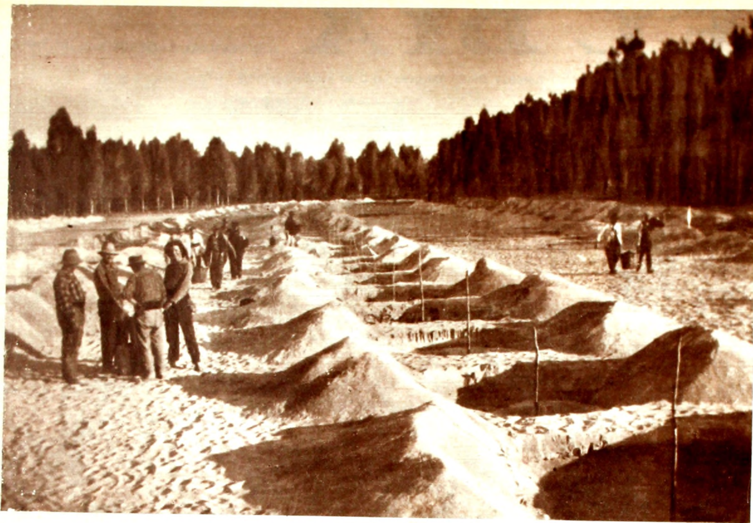
Trabajos de desmonte y plantación de una de las grandes avenidas.
