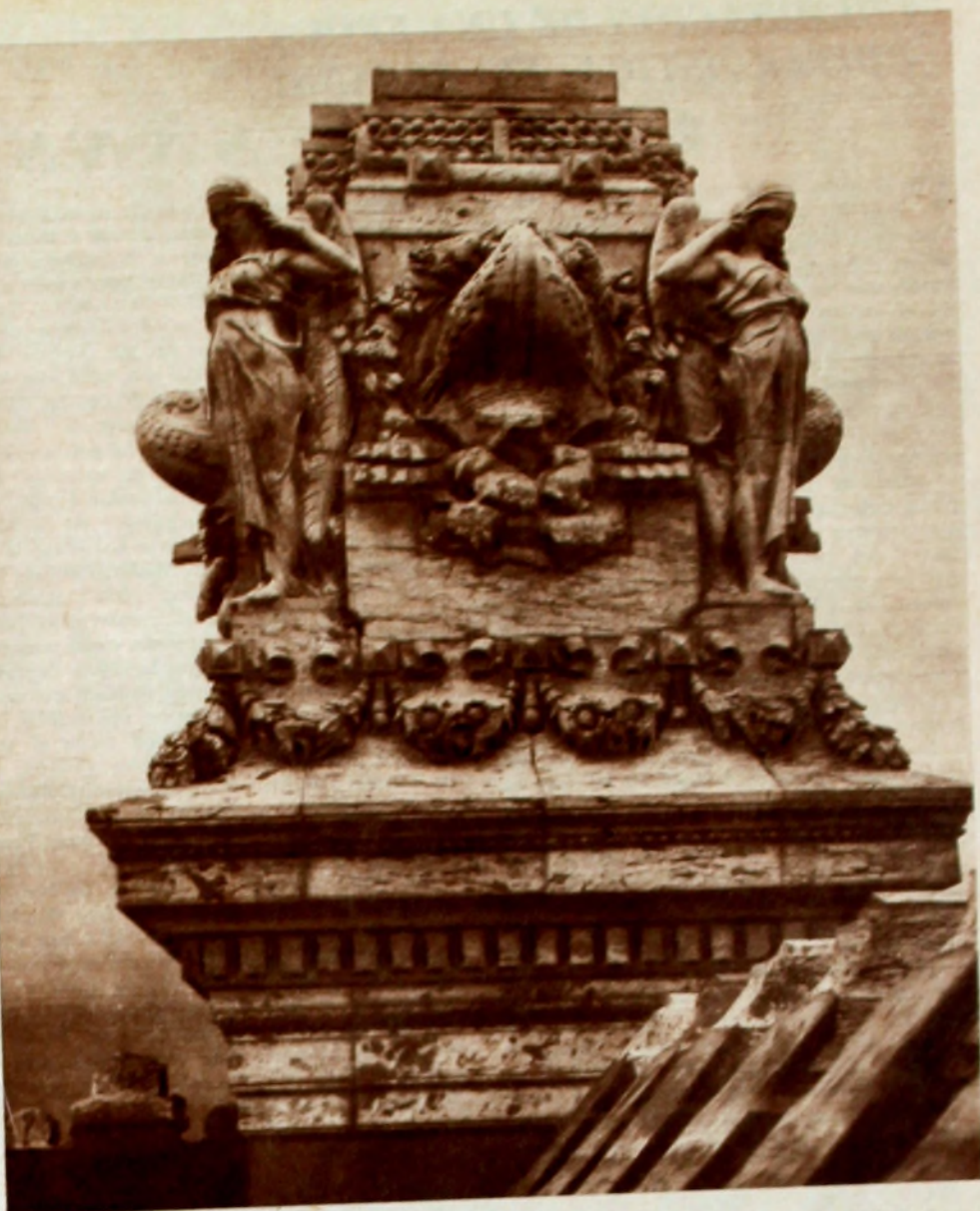
Remate de uno de los pilares del cuerpo central que corona el palacio.
