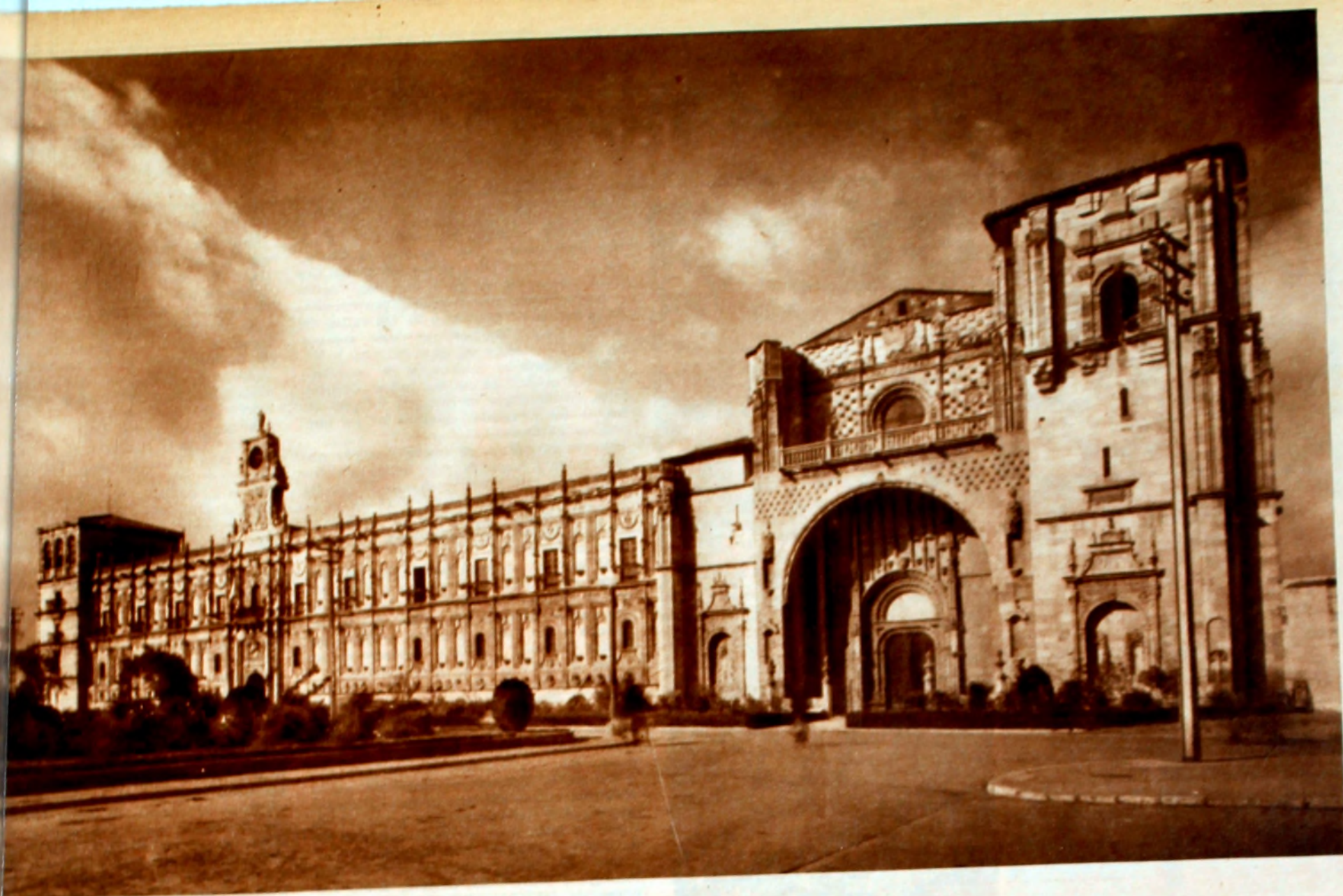
Arias Montano y Quevedo, moraron aquí. Fachada de San Marcos.
