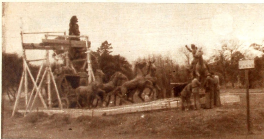
Apenas fue instalada la diligencia, obreros especializados coordinan el conjunto.
