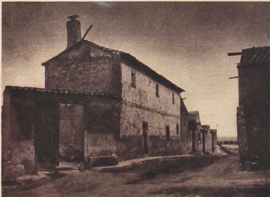
Esquina frontera a la casa de Doña Catalina.
