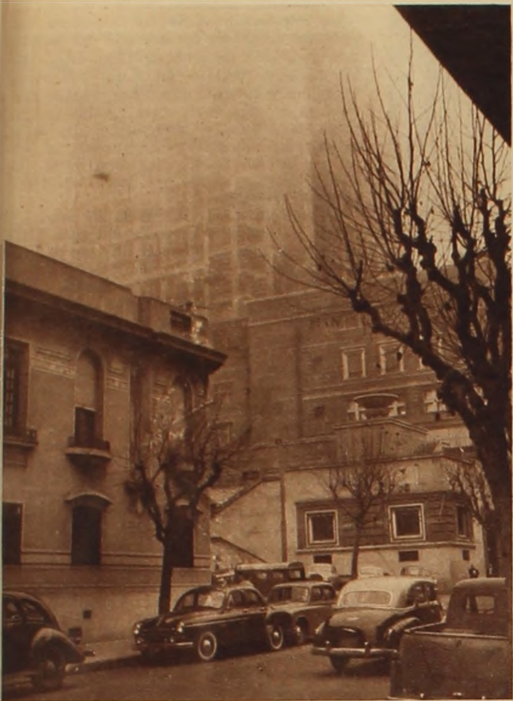
Afincándose en el ramaje de árboles desnudos.
