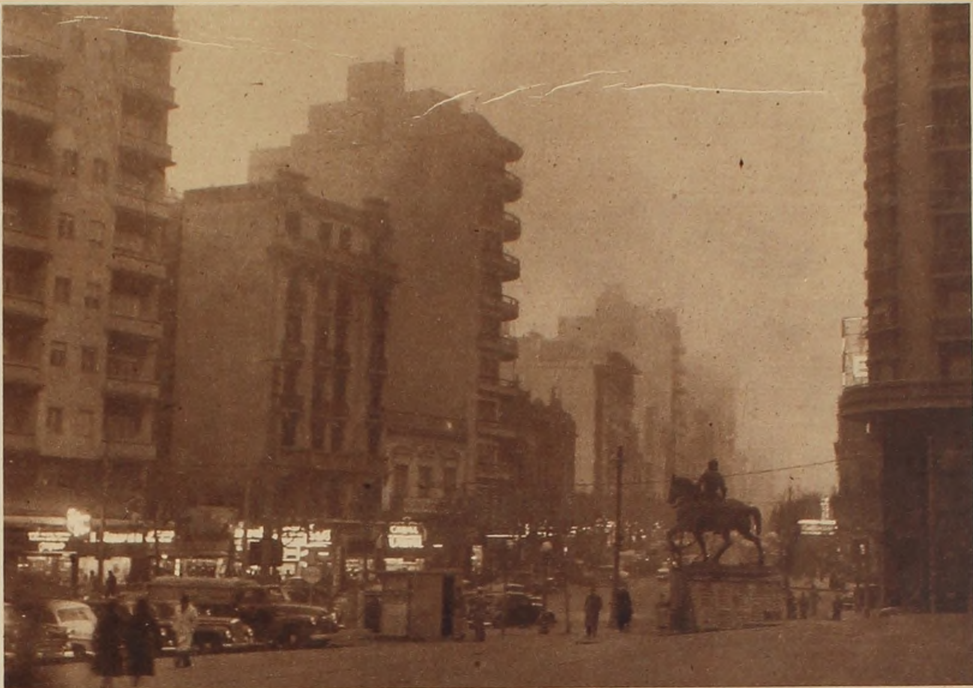
Las luces encendidas a la media tarde y como borrando de a una las colosales moles de cemento.
