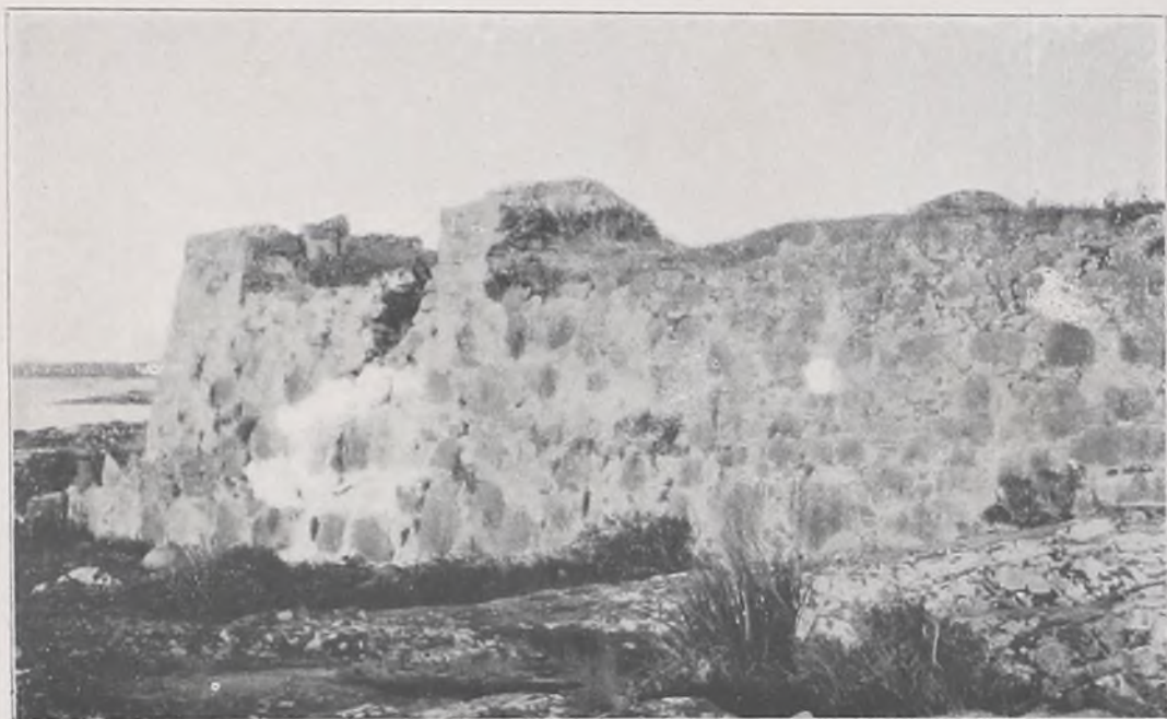
Fig. 29. — Bateria de San Pedro (Vista B)
