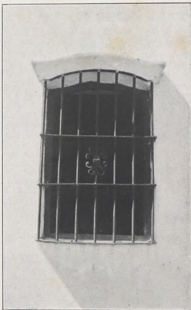
Fig. 99. — Detalle de una ventana
