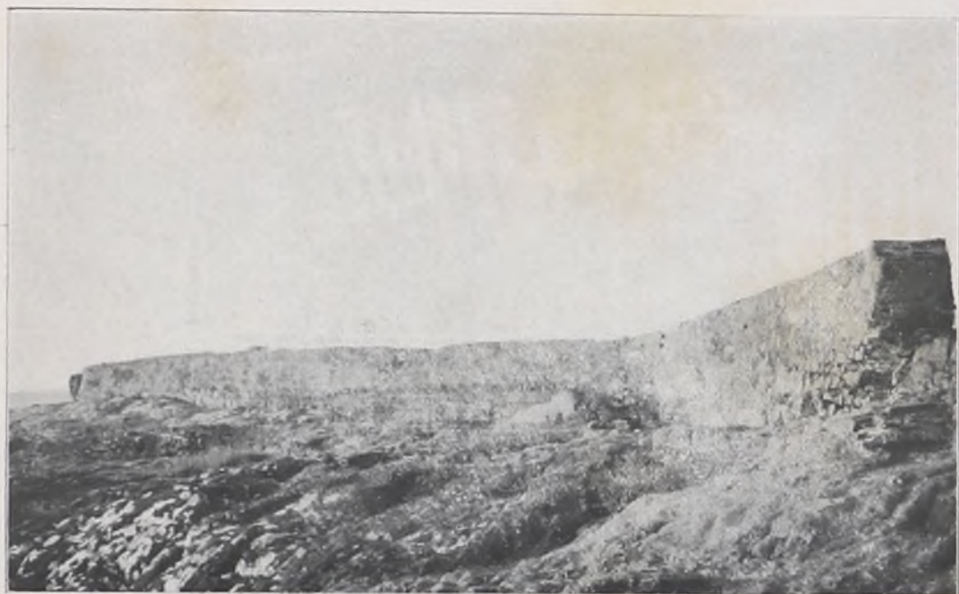
Fig. 32. — Murallas. Vista A
