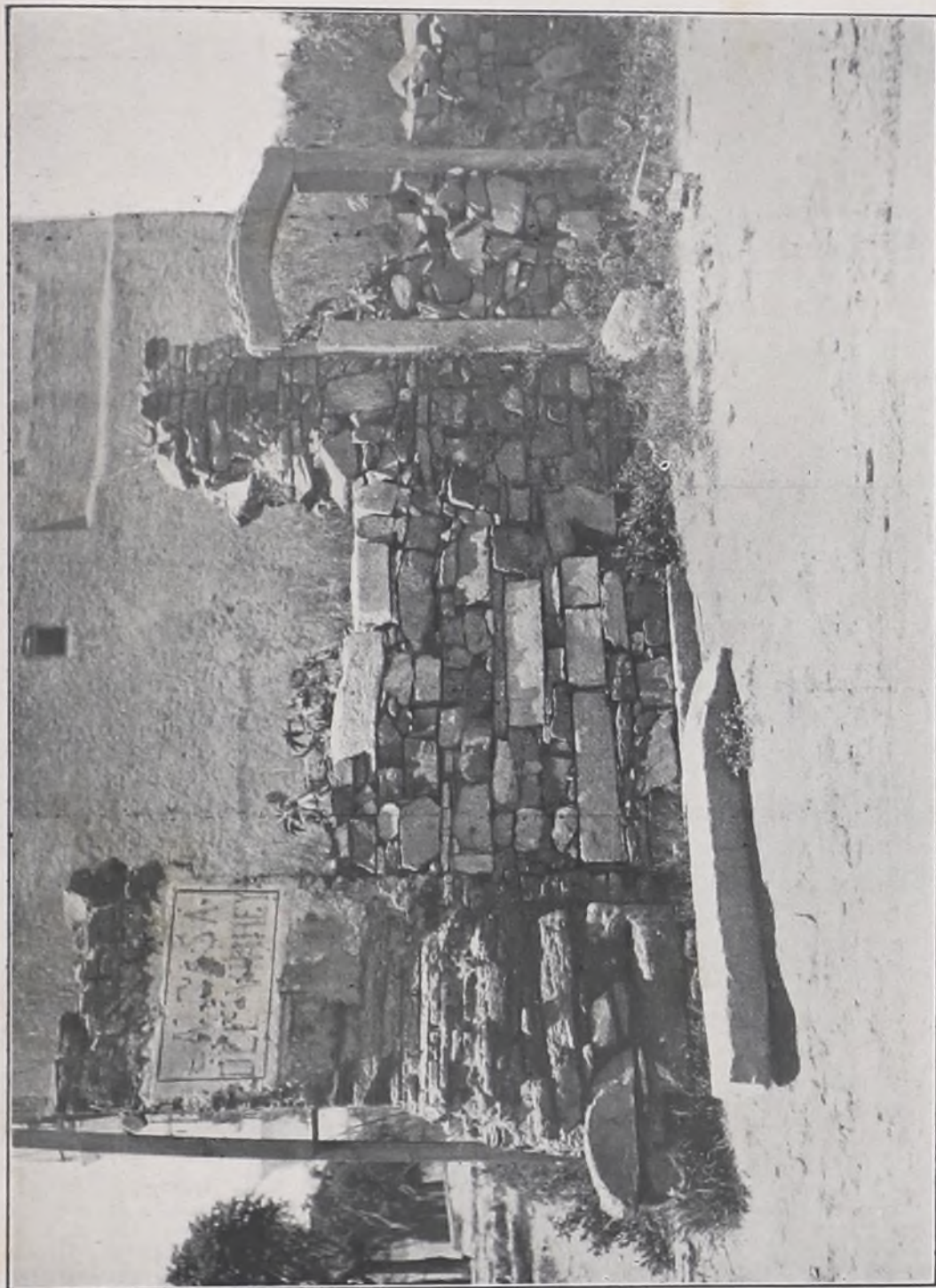
Fig. 69. — Trozo de muro de la casa del Virrey, de piedra grisácea. Obsérvese la entrada formada por jambas y arco escarzano monolíticos. Dimensiones; m. 13 × 18
