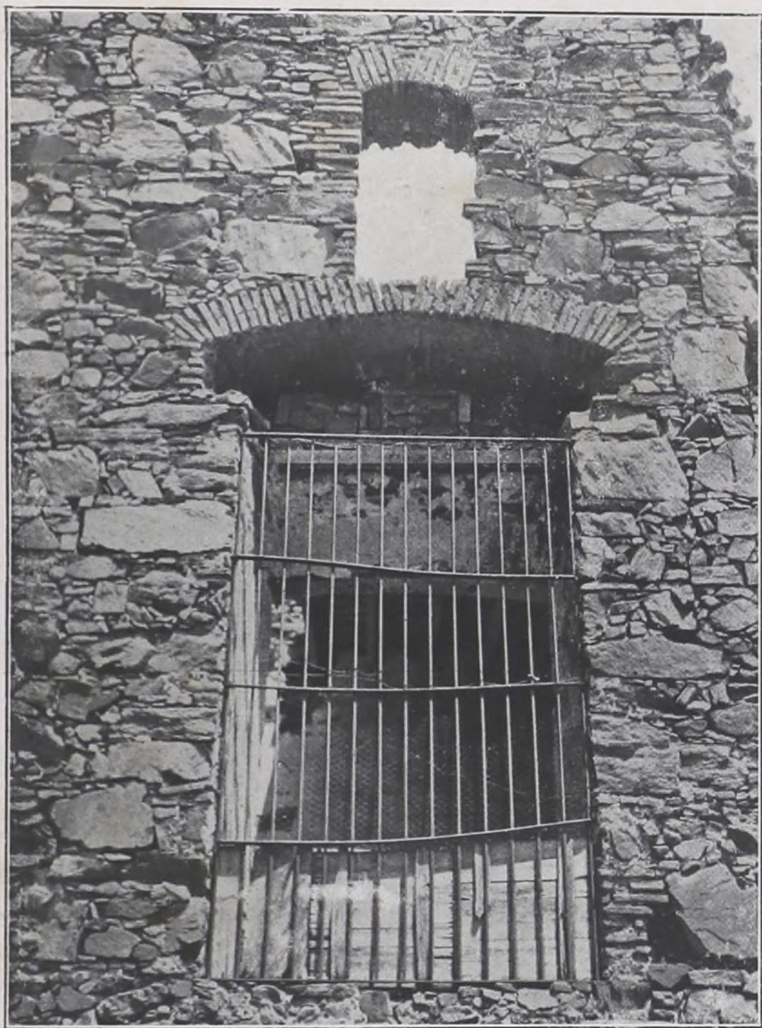
Fig. 54. — Muro del convento de San Francisco, dispuesto en "opus incertum" con ladrillos intercalados y la construcción de los arcos en ladrillo.
