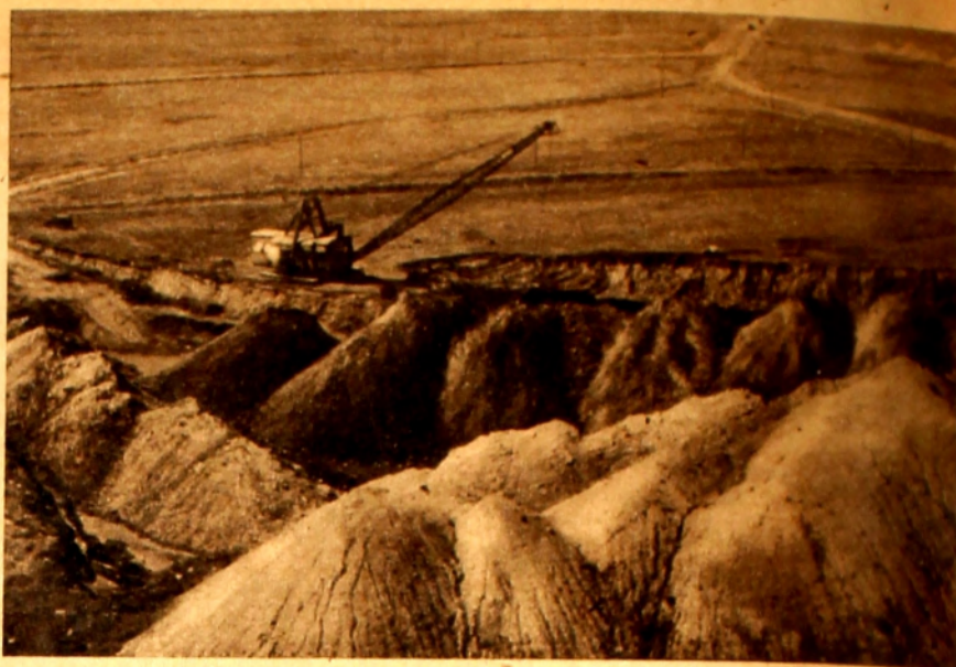
Para realizar en forma eficiente la extracción de mineral en los yacimientos carboníferos de Saskatchewan, se emplean estas gigantes palas mecánicas a propulsión eléctrica, que desfilan sobre enormes deslizadores.
