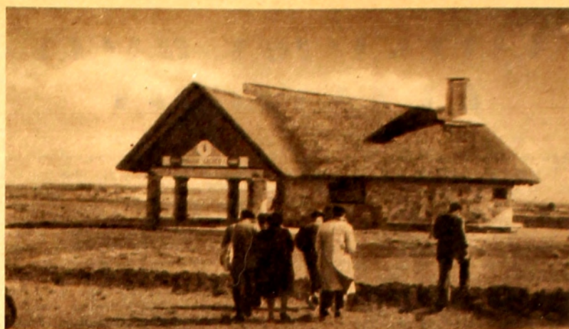
El pequeño parador levantado junto al borde de panorámicas barrancas, en el área que se destina a la instalación de un zoológico.
