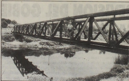
PUENTE ARROYO CARRASCO
