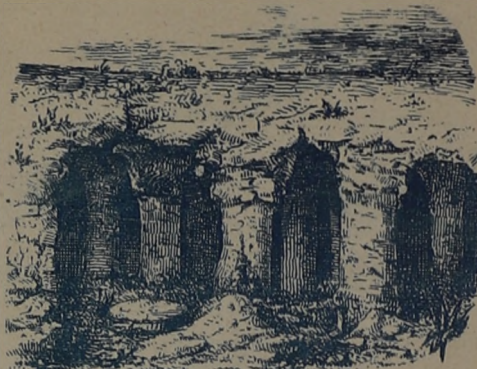
SUBTERRÁNEO DE LOS INDIOS DESCUBIERTO EN EL DEPARTAMENTO DE FLORES
