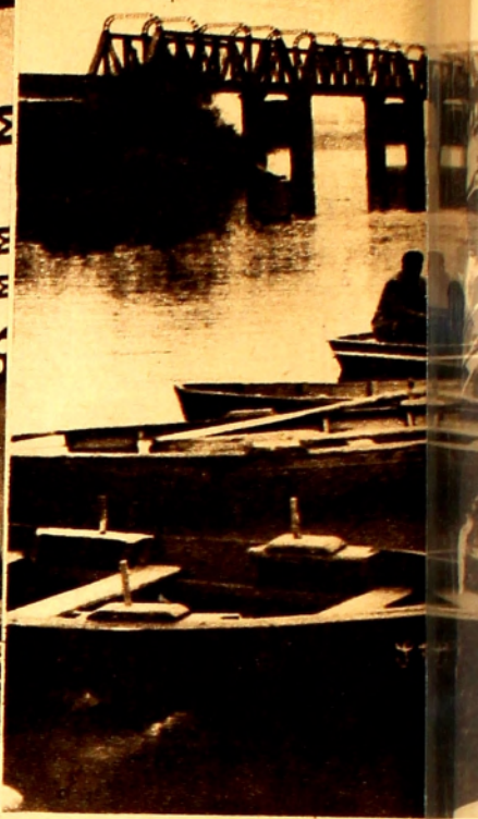
puente Internacional ferroviario sobre el río Cuareim. Se aspira a que este puente facilite el tránsito de vehículos, ahorrando por las lanchas que se usan.
