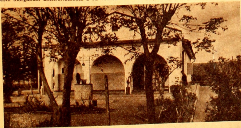
Parte posterior de una escuela de Cardona, con sus arcos de medio punto que recuerdan las casas campesinas "riu-rau", de la provincia de Alicante (España).
