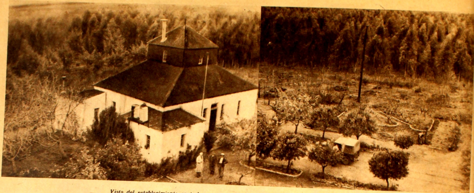
Vista del establecimiento central y parte del bosque, tomada desde la torre de vigilancia.
