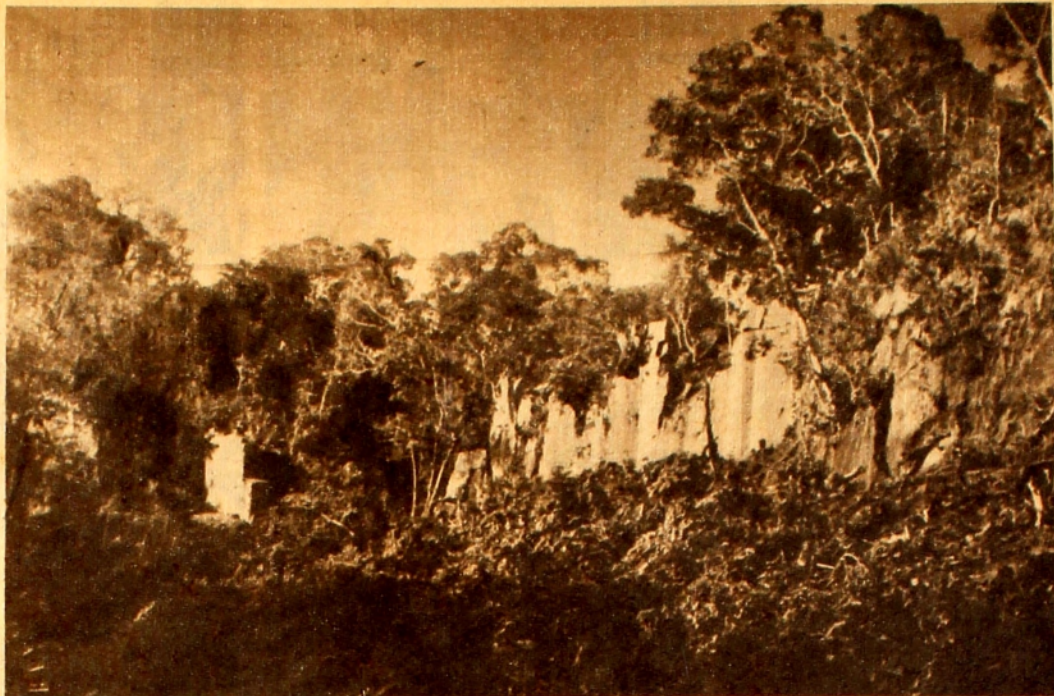
Las murallas antes de su limpieza.
