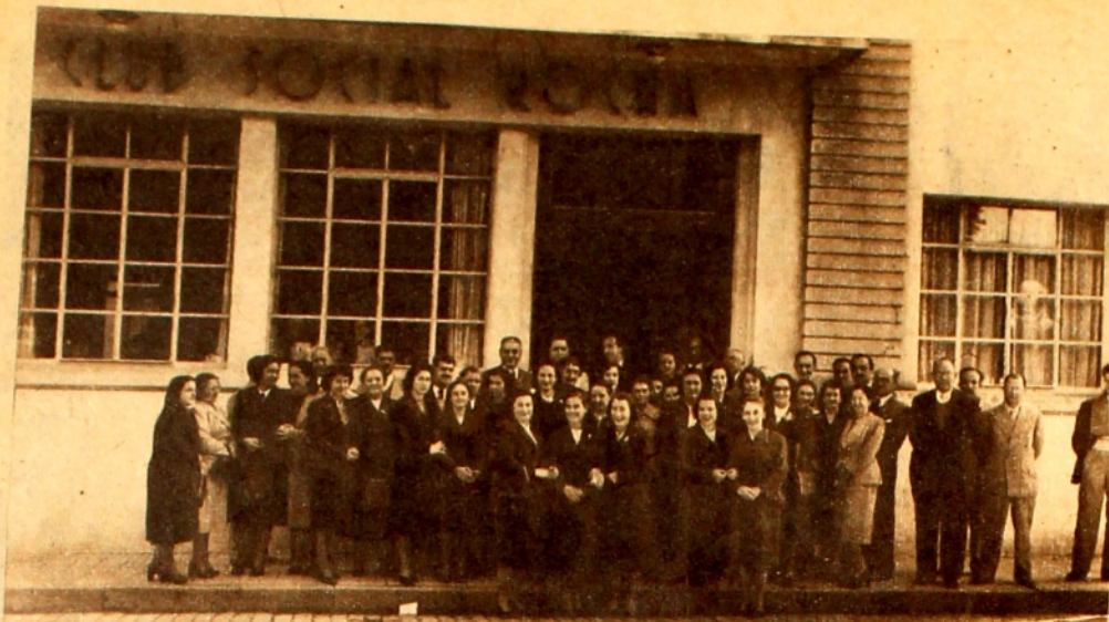
Parte del frente del edificio propio, situado en uno de los puntos más céntricos de Rocha. Esta nota gráfica fué tomada en ocasión de ser visitado el prestigioso centro por una delegación de educacionistas.
