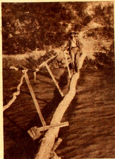
Puente de construcción muy primitiva en la zona de los garimpos del Alto San Lorenzo.
