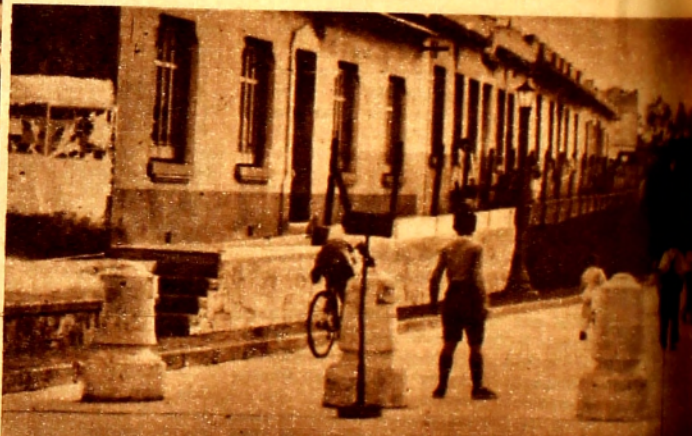
Adaptación de la ex-vía del ferrocarril, en la calle L...
