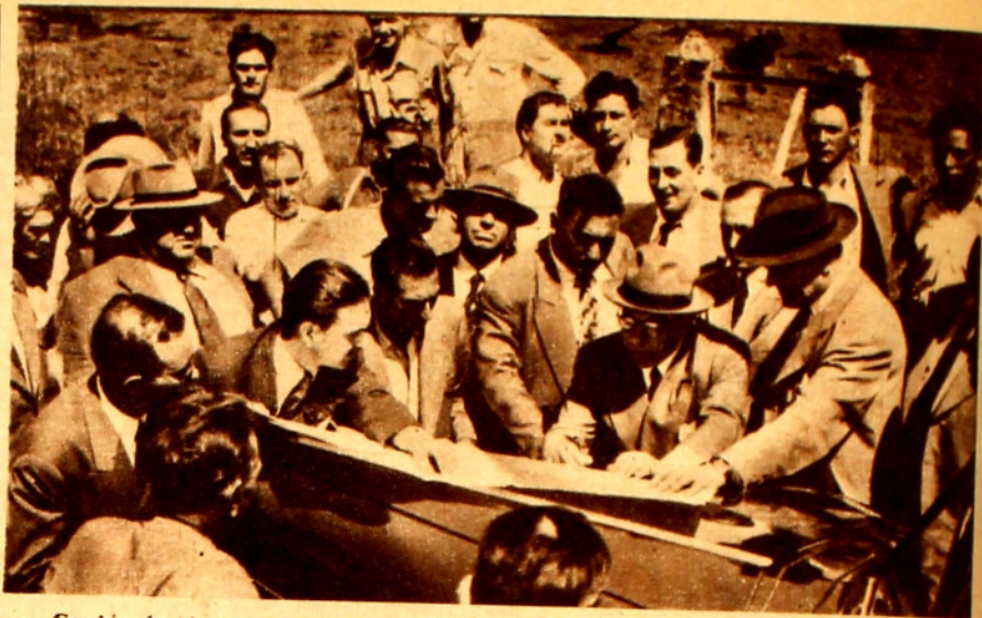
Cambiando ideas con los vecinos sobre construcción de caminos en zona próxima a Santiago Vázquez.
