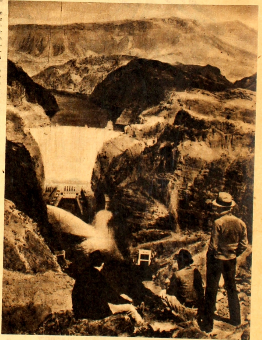
Conjunto de represa y usinas de Boulder Dam, en río Colorado (Norte América), obra máxima de la ingeniería cuya represa tiene una altura de 220 metros.
