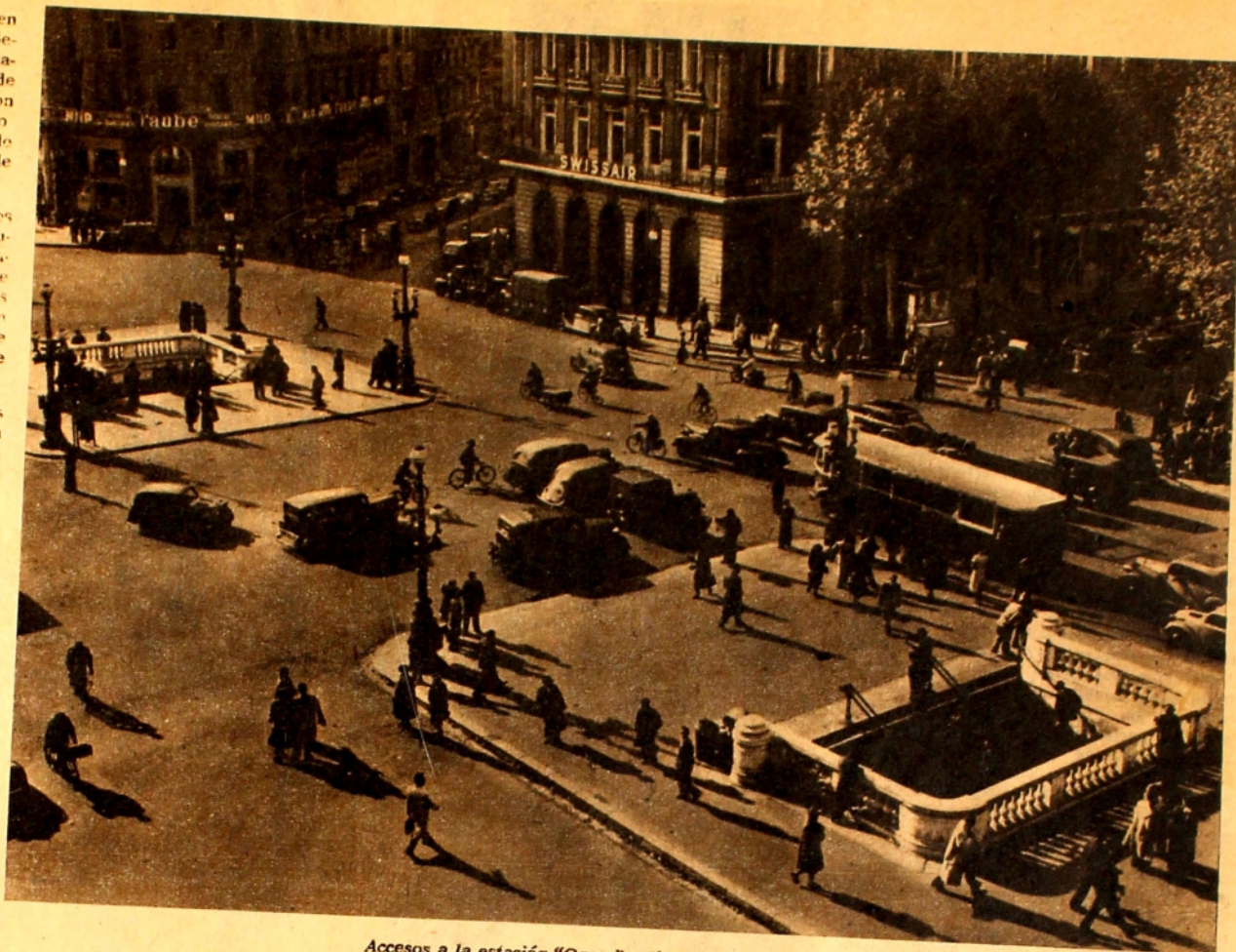
Accesos a la estación "Opera" y líneas Nos. 3, 7 y 8.
