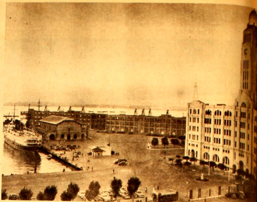
*Perspectiva de las explanadas, depósito y edificio de la Aduana, vista desde uno de los ventanales de la Administración Nacional de Puertos.
