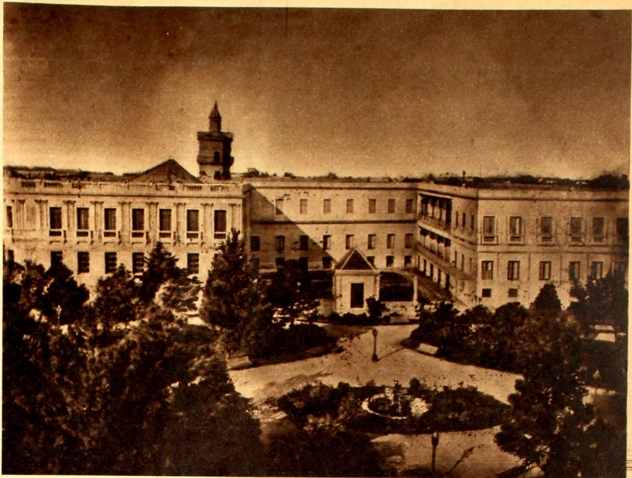
Asilo de Mendigos. 1860-1919, en el edificio del Colegio. (Fotografía de 1903 de Mr. Patod).
