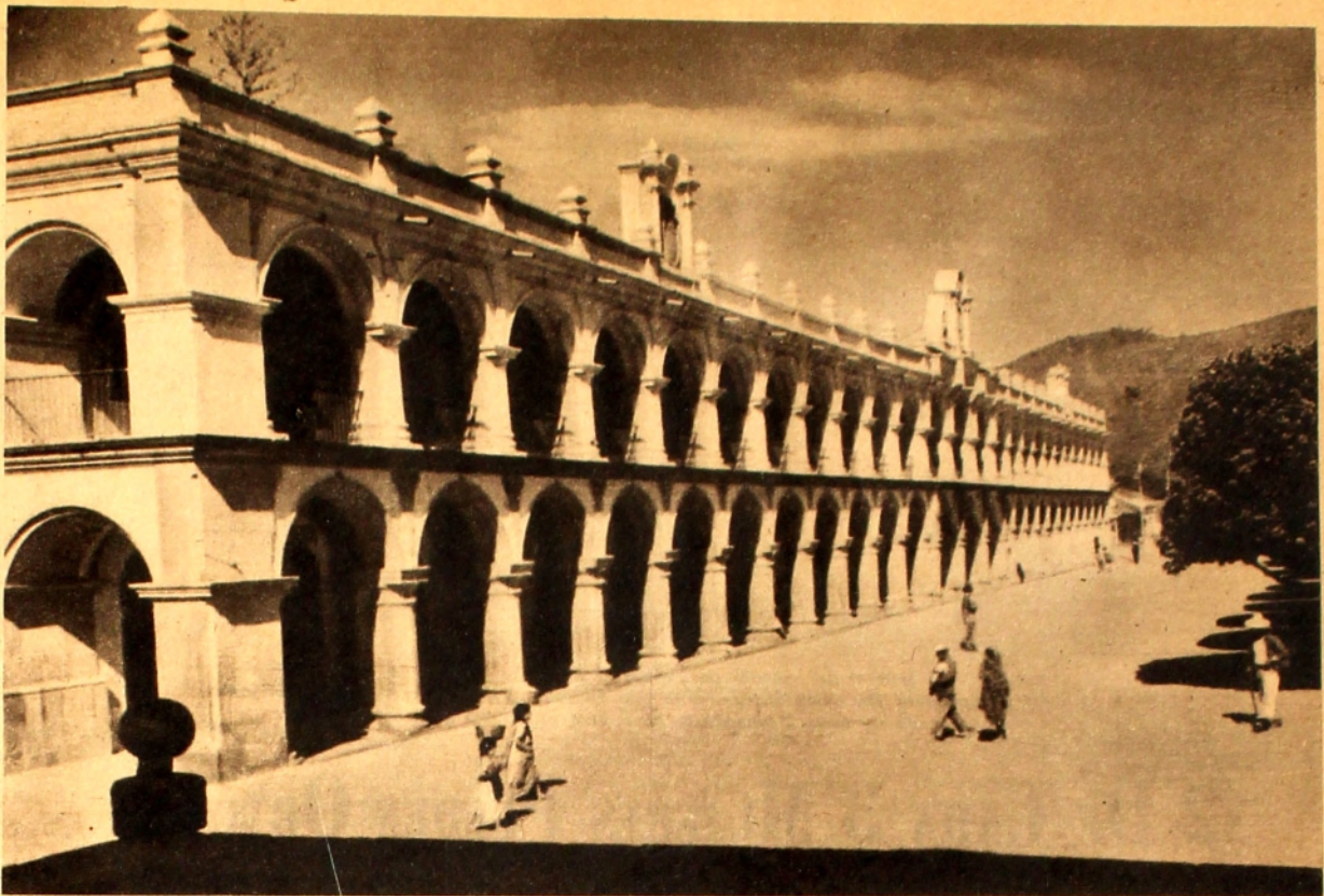
Vista del Palacio de los Capitanes, en Antigua Guatemala.
