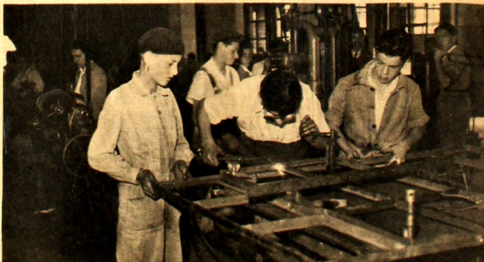
Práctica de soldadura con gas.
