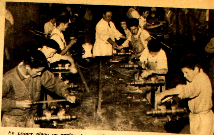
En primer plano un equipo de aprendices de ajustadores. En segundo plano dos equipos de futuros torneros. Al fondo, soldadores.
