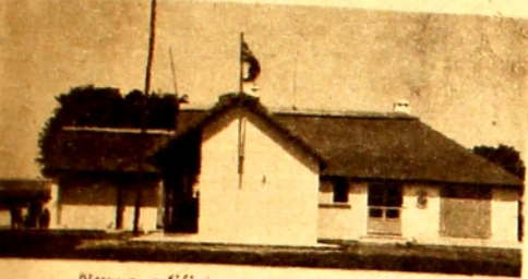
Nuevo edificio de la Escuela Rural N° 10 de El Ceibo que viene a sustituir a los ranchos en los que funcionaba, y en los que habitaba el maestro. Hace cincuenta años que se mantenía en ruínosa situación en medio de un palmar inundable, rodeado de charcos, pantanos, cañadas y esteros interminables e intransitables. La actual Directora es la señorita Agustina Z. Fischer.
