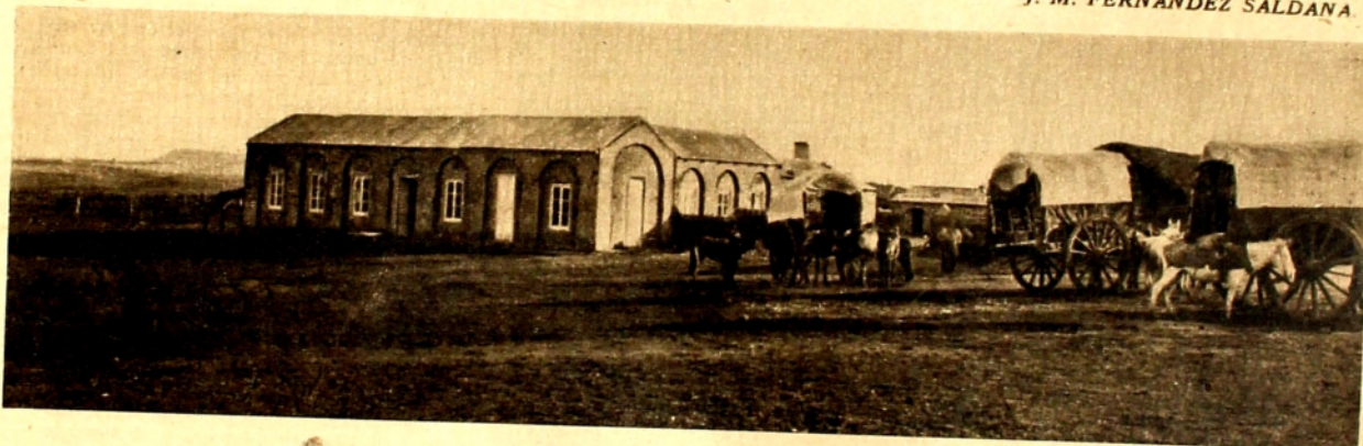
Carretas descargando materiales.
