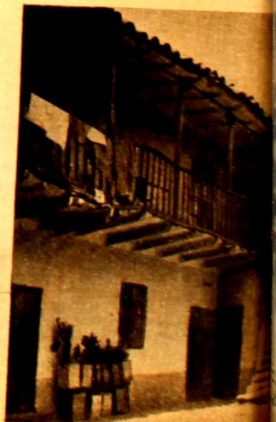
Pintoresco patio de una antigua casona. Típica la escalera que se ve a la izquierda.
