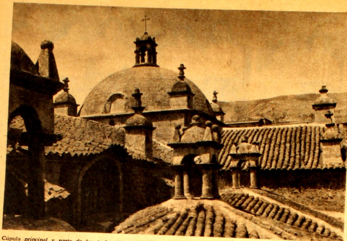
Cúpula principal y parte de los techos de San Francisco. A la derecha se ven dos de los lucernarios que iluminan una de las naves laterales.
