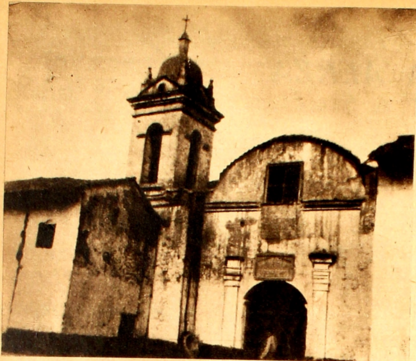
Templo convertido en garage. La curia dejó el edificio que amenazaba desplomarse.
