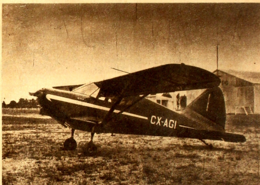
Vista lateral del avión de los ingenieros Neyeloff y Barrandeguy, donde se observa claramente, como se asimila al perfil de la "barriga", el cajón de vigas cantiliver donde se guarda el tren.
