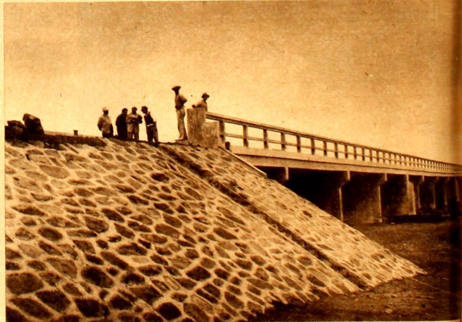
Puente sobre el arroyo Batovi, en el Departamento de Tacuarembó.
