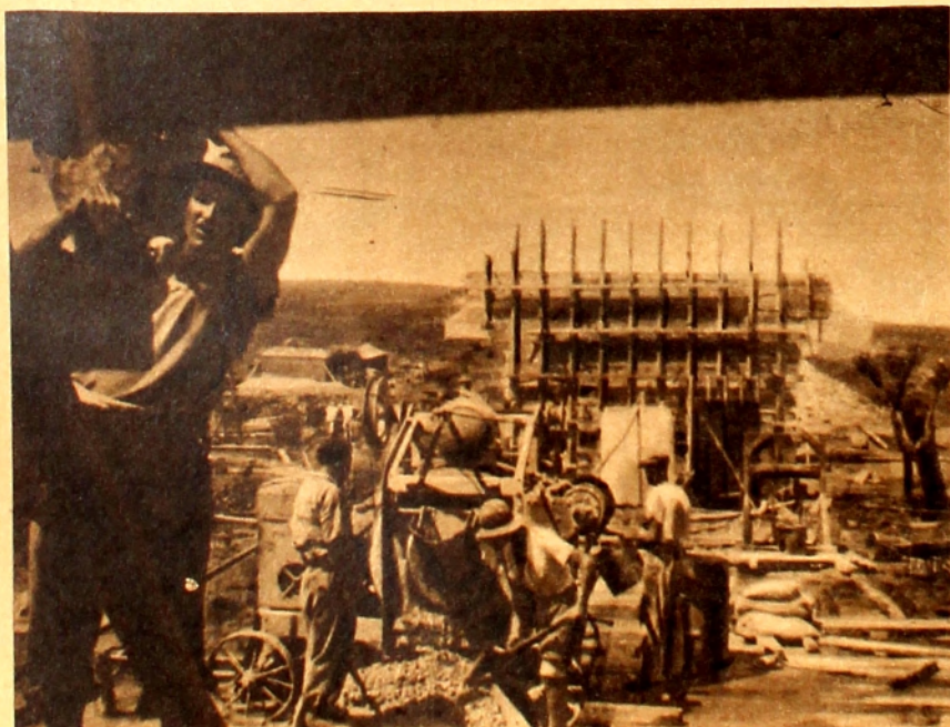
Trabajos de hormigonado en el Puente Curticeras, de la ruta N.º 5.
