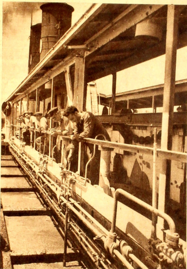
Vista de uno de los puentes de maniobras y bodegas de carga en plena carga, puede verse a los funcionarios midiendo la densidad del material extraído.
