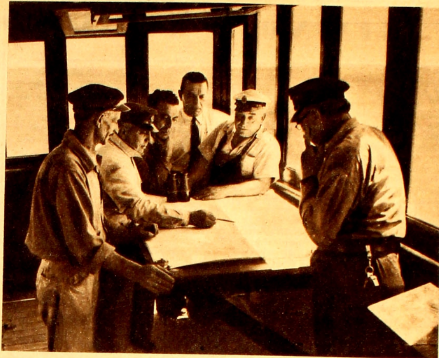
La mesa de estudios donde puede verse a la oficialidad de a bordo, analizando los planos de uno de los complicados trabajos que está efectuando la draga "D 5".
