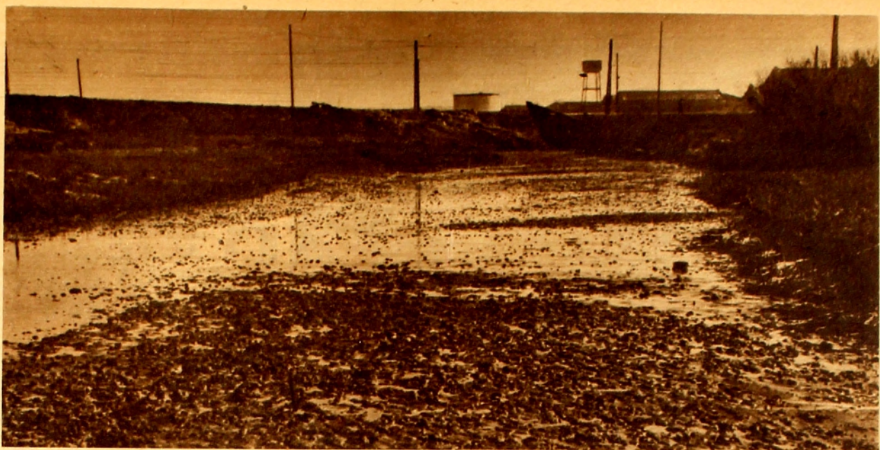
ZONA DEL PANTANOSO, "TIERRA DE NADIE", NI DE LA BAHIA NI DE LOS HOMBRES, Y QUE LOS TECNICOS HAN HECHO SERVIR ADMIRABLEMENTE PARA LA INICIADA CONSTRUCCION DE DIQUES FLOTANTES EN CEMENTO ARMADO.
