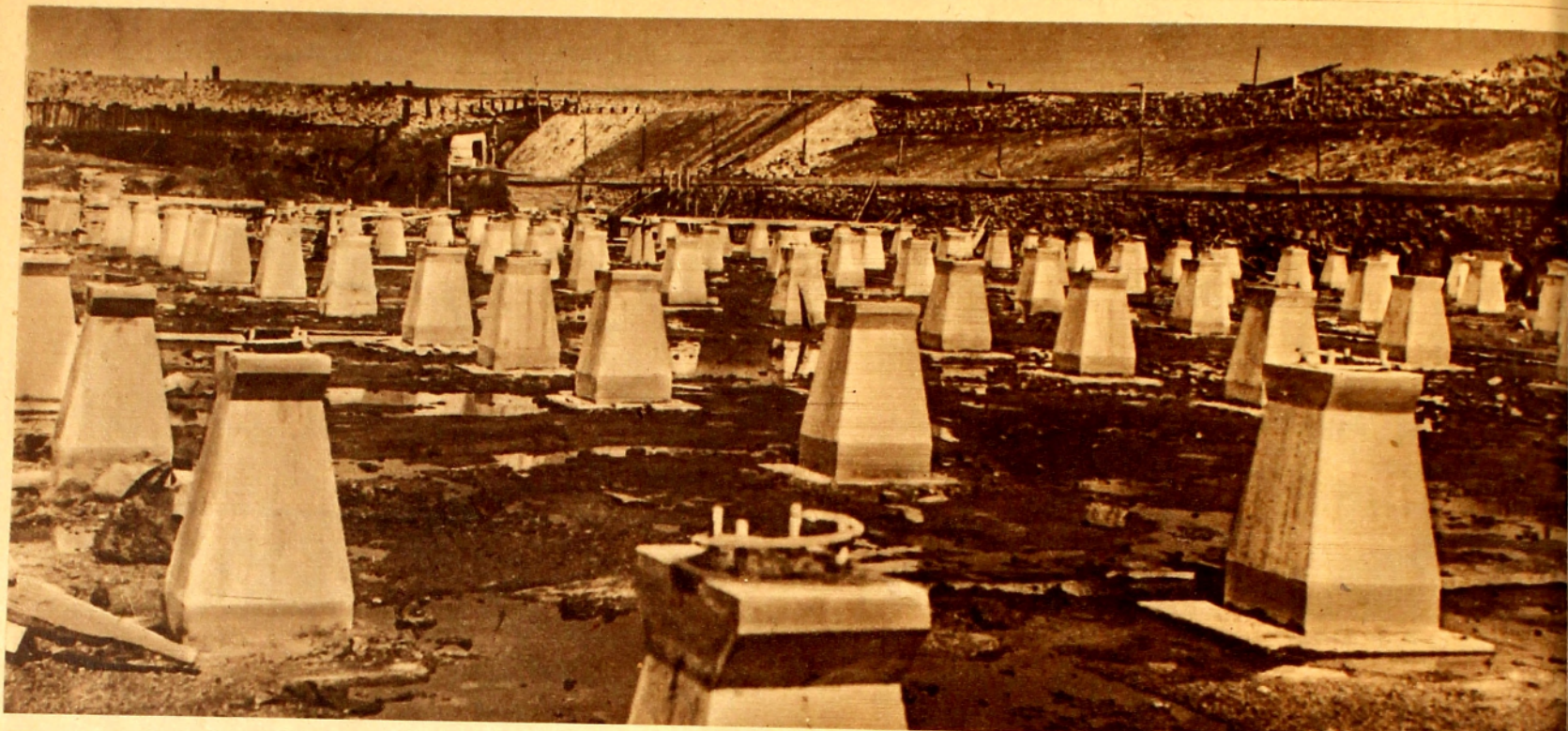
FONDO DEL "BASIN", QUE MAS BIEN PARECE LAS RUINAS DE UN "FORO" IMAGINARIO. SOBRE LA SUPERFICIE DE ROCA YA NIVELADA Y DESECADA, APARECEN LOS PILARES DE CONCRETO QUE SOPORTARAN LA BASE PLANA DEL FUTURO DIQUE FLOTANTE, A LA MANERA QUE LAS CUÑAS DE MADERA SOPORTAN EN LOS ASTILLEROS, LA QUILLA DE LOS BARCOS. A LA DERECHA, UNO DE LOS MUROS DE CONTENCIÓN LATERALES DEL "BASIN". AL FONDO, A LA IZQUIERDA, LAS ATAGUIAS O DEFENSAS PROVISORIAS DE AGUA EN EL LUGAR DONDE IRAN LAS COMPUERTAS.
