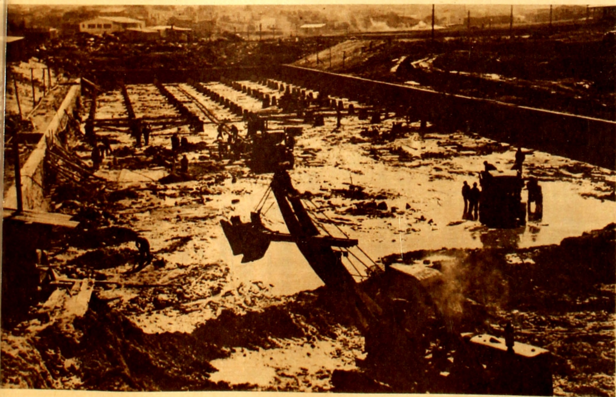
EN PRIMER PLANO, LAS PALAS MECANICAS Y LOS CAMIONES TRABAJANDO Y RETIRANDO EL BARRO. AL FONDO, LOS ASTILLEROS Y LA "CUNA" PARA EL PRIMER DIQUE FLOTANTE, QUE PROXIMAMENTE SERA COMENZADO.
