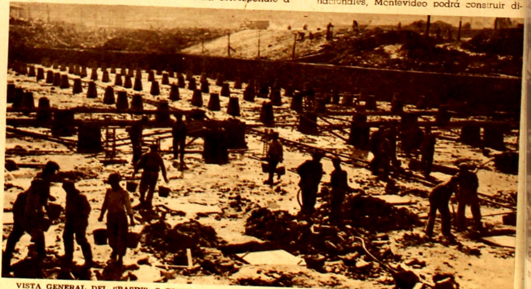
VISTA GENERAL DEL "BASIN", O DIQUE PARA DIQUES FLOTANTES, CUYA CONSTRUCCION SE REALIZA EN EL PUERTO DE MONTEVIDEO. FOTOGRAFIA TOMADA DESDE EL PUNTO EN QUE SE COLOCARAN LAS COMPUERTAS DE COMUNICACION CON LA BAHIA.
