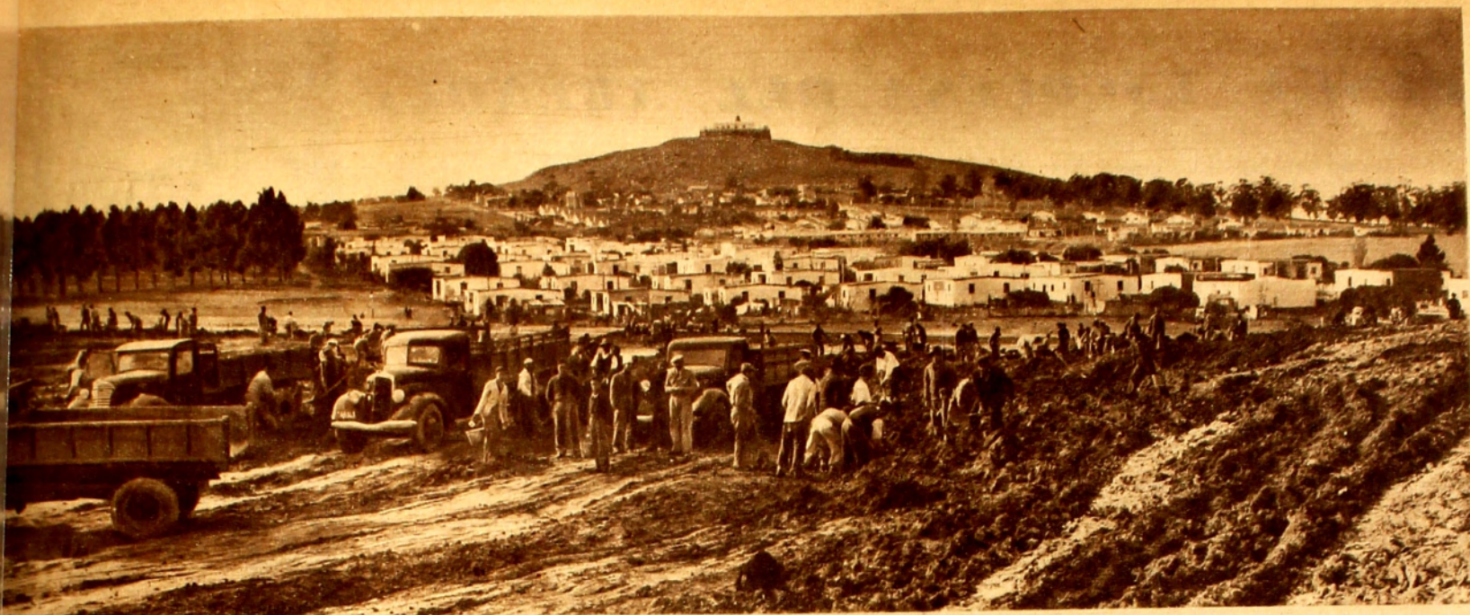
TRILOGIA DE TRABAJO, PINTORESQUISMO Y EVOCACION HISTORICA. AL FONDO, EL CERRO, CUYAS BATERIAS CUSTODIABAN LA BAHIA Y EL RINCON DE LAS CABALLADAS DEL REY.
