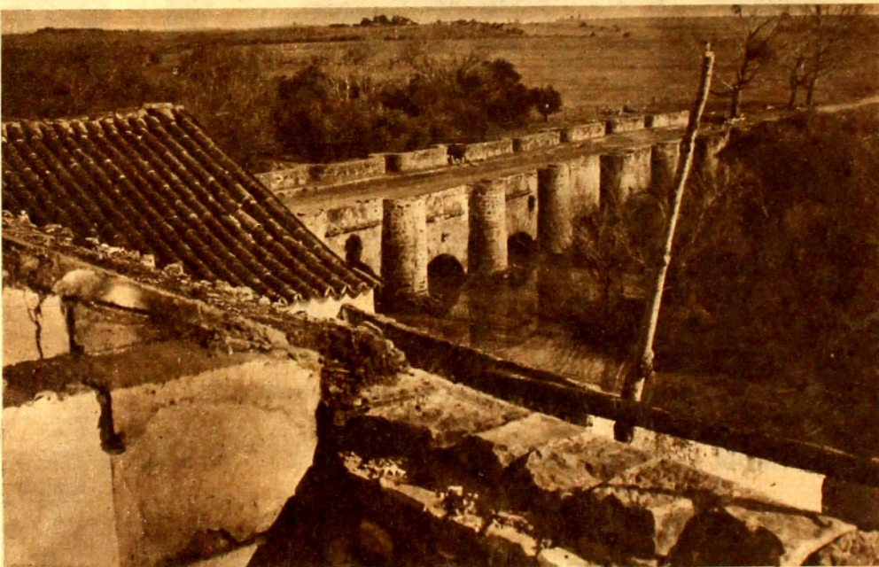
LA CASA DEL PEAJERO Y LA GLORIETA, DESCANSO DE SOMBRA PARA EL TRANSEUNTE, Y LA TERMINACION SUPERIOR DE LOS PILARES, FORMANDO BALCONES NATURALES COMO PARA LA OBSERVACION DEL PAISAJE
