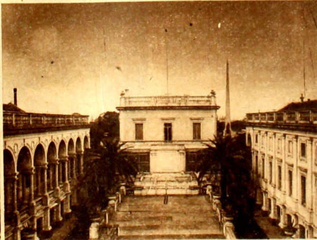
VISTA CENTRICA DEL INTERIOR ABIERTO QUE DIVIDE LAS GALERIAS. PATIO ENJARDINADO. Y AL FONDO, EDIFICIO DEL ACTUAL SANATORIO.
