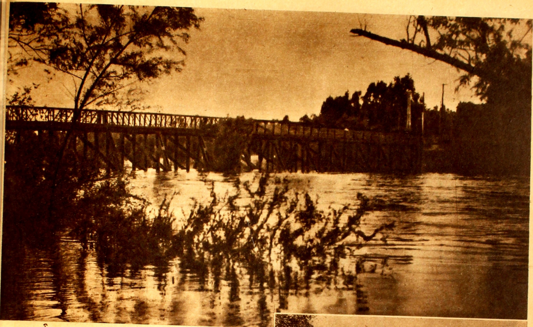
↑ EL RIO YI, ALGO CRECIDO, PASANDO DEBAJO DEL PUENTE CARRETERO
