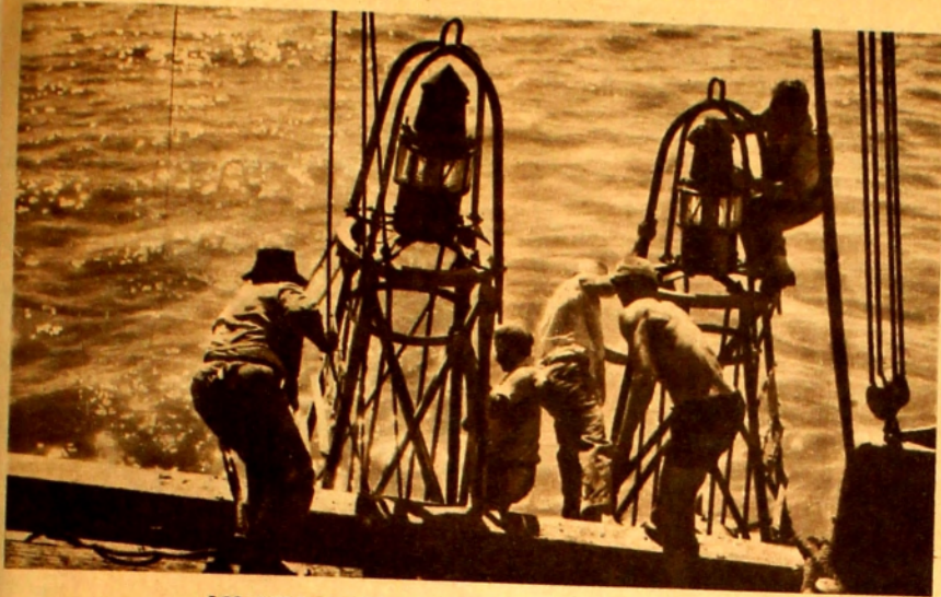
LOS OBREROS DEL "C.9" TRABAJANDO EN DOS BOYAS
