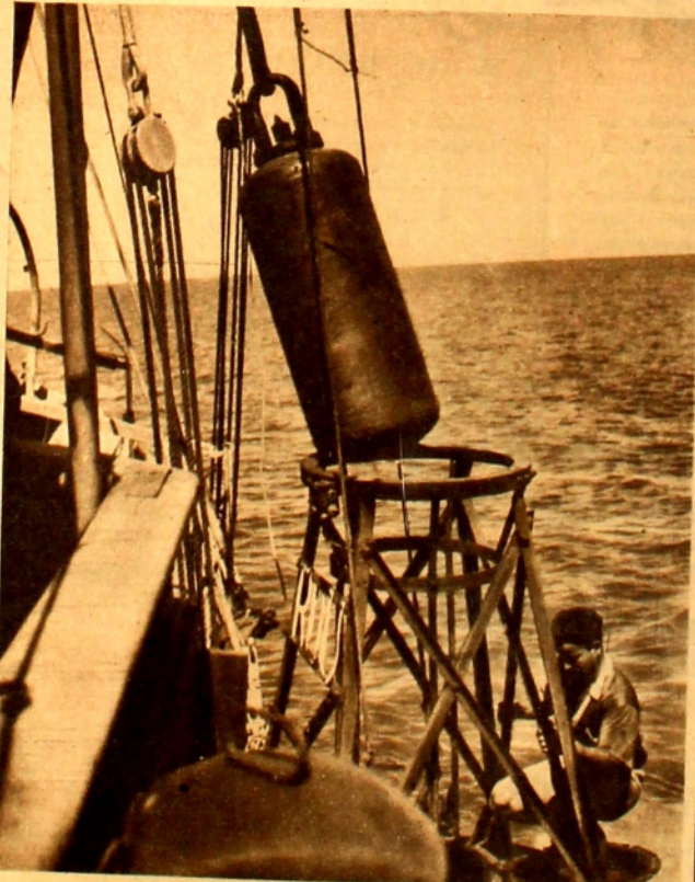
INSTANTE EN QUE ES INTRODUCIDO EN UNA BOYA UN TUBO DE ACETILENO QUE LA MANTENDRA ENCENDIDA POR ESPACIO DE CINCO MESES.
