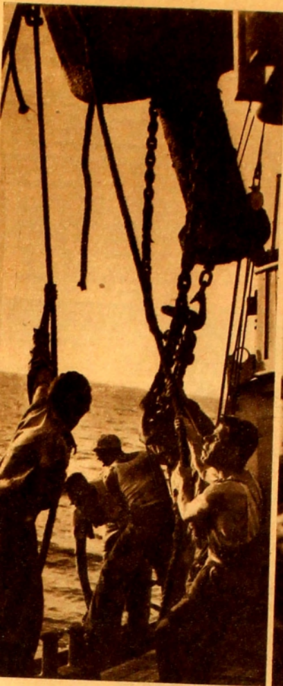
REPARANDO LAS FALLAS DE UNA CADENA DE LA BOYA.
