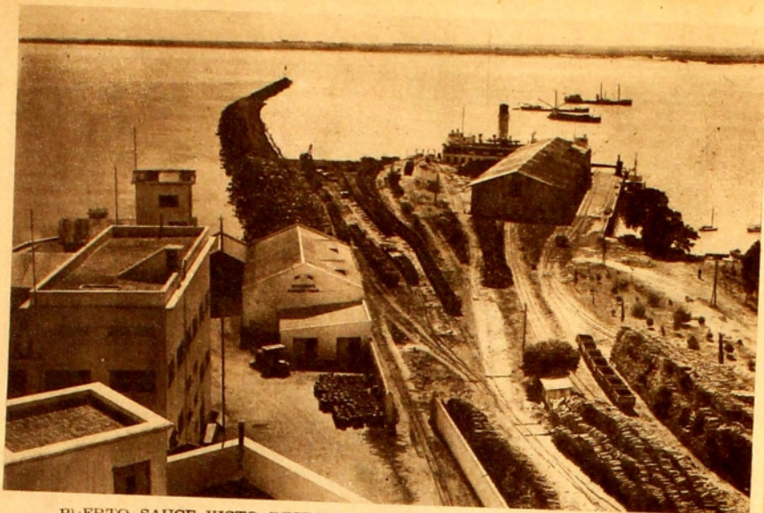
PUERTO SAUCE VISTO DESDE EL EDIFICIO QUE OCUPA LA FABRICA DE CELULOSA.
