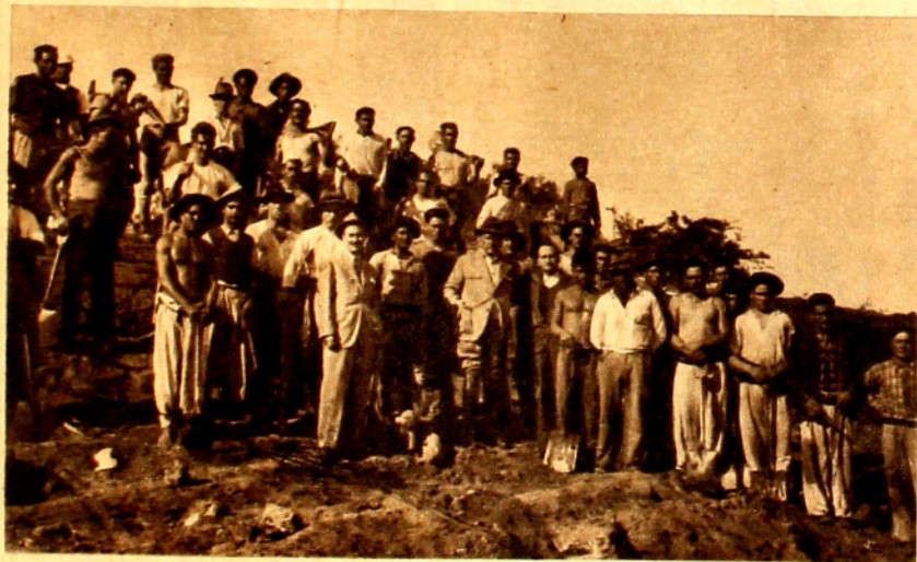
EL NUMEROSO PERSONAL QUE TRABAJA EN LA CONSTRUCCION DE LA CARRETERA EN LAS PROXIMIDADES DE MELO, RODEA AL MINISTRO DE OBRAS PUBLICAS.
