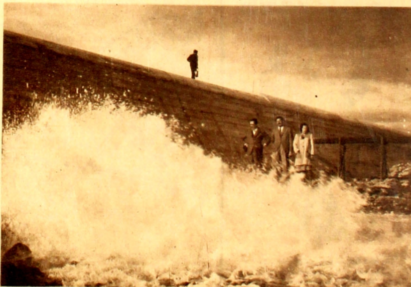
DESCARGA DE FONDO EN LA REPRESA DEL SISTEMA EXPERIMENTAL "A-1".
