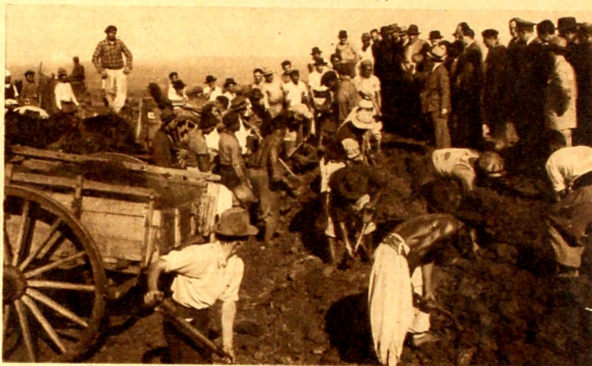
EN LAS PROXIMIDADES DE MELO, LOS OBREROS DE LA EMPRESA BARRANDEGUY-NEYELOFF, CONSTRUYEN UN TROZO IMPORTANTE DE LA CARRETERA.
