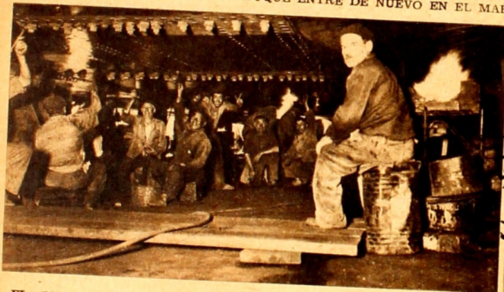
EL CASCO DE LA PODEROSA NAVE ES REPARADO. NUMEROSOS OPERARIOS ESPECIALIZADOS SUSTITUYEN LAS PLANCHAS AVERIADAS POR OTRAS NUEVAS Y RESISTENTES, EN MEDIO DEL FULGOR DE LAS FRAGUAS QUE PONEN EL METAL AL ROJO Y DEL RUIDO INFERNAL DE LAS REMACHADORAS.
