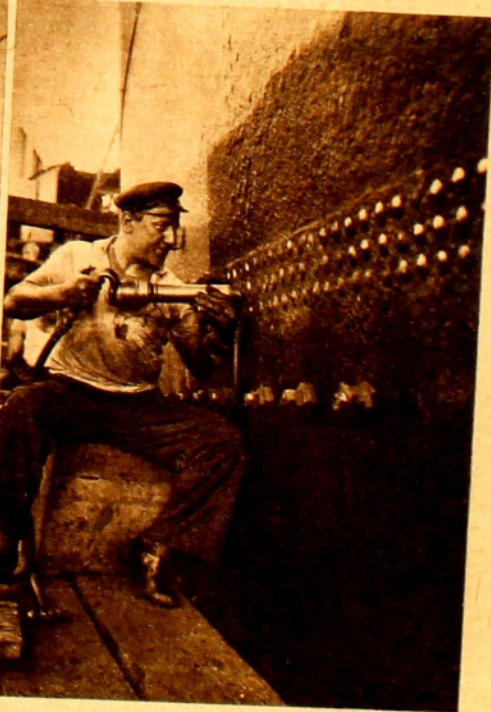
FUERZA Y HABILIDAD EXIGE LA OPERACION DE COLOCAR REMACHES PARA UNIR LAS PLANCHAS DEL CASCO.
